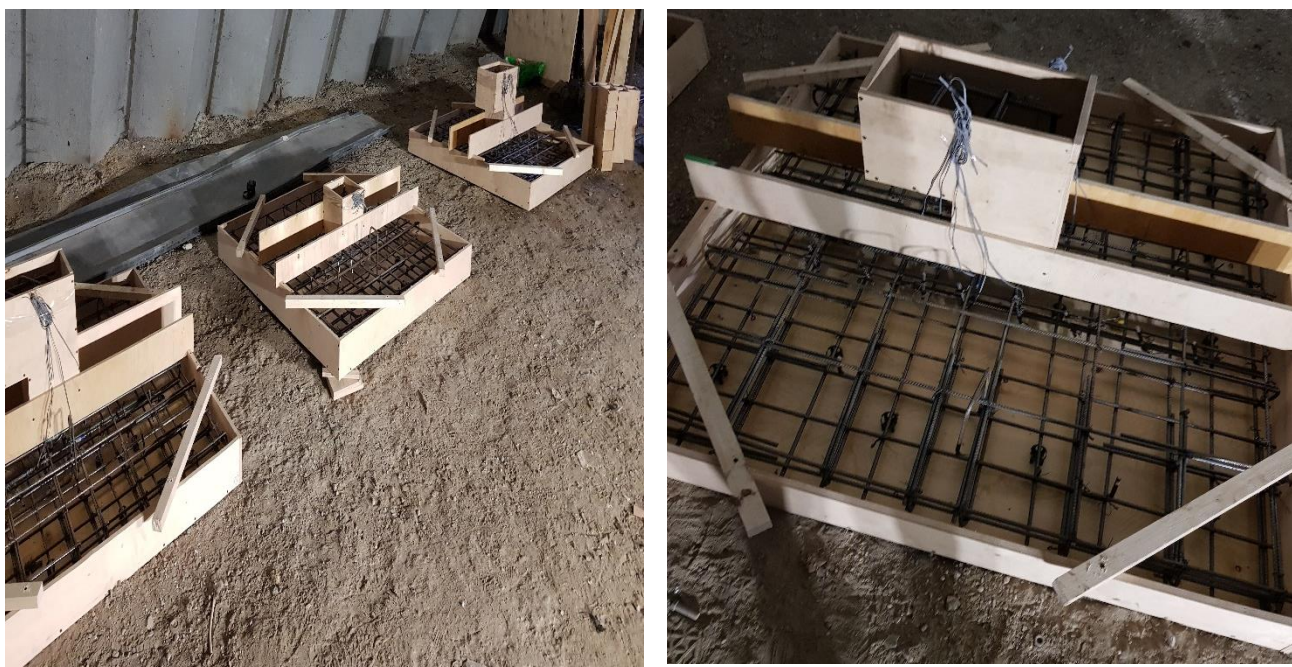
Рисунок 2.4 – Устройство опалубки образцов
